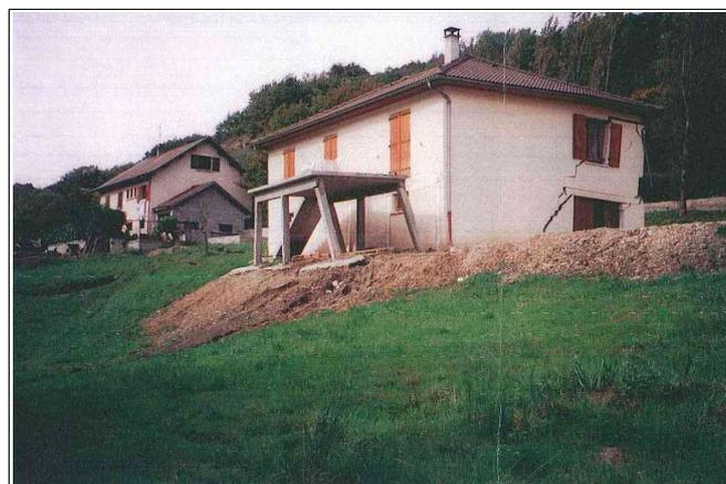
Une maison située à l'aval de la RD56 a été fortement endommagée. Elle a dû être démolie. On notera les fissures sur ses façades et le décolllement de la terrasse de la façade aval. On remarquera également la faible pente du terrain.
